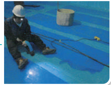
PE Welding Fusion
